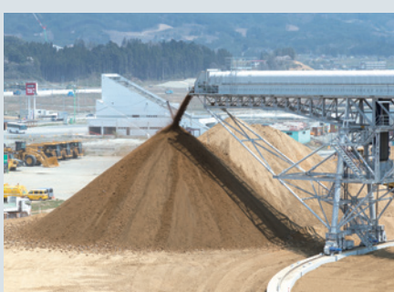
陸前高田市震災復興事業におけるベルトコンベヤによる土砂搬送(写真提供：清水建設株式会社)
