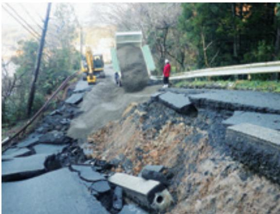
大規模な路肩崩壊と亀裂の応急補修
