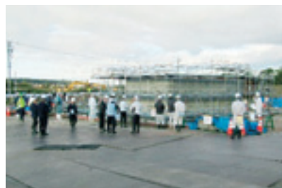
内灘排水機場建設工事
