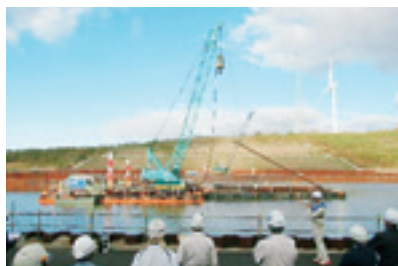
河北潟放水路防潮水門建設工事
