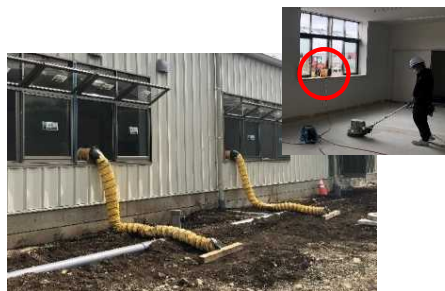
送風機を稼働し、埃を外部へ排出
