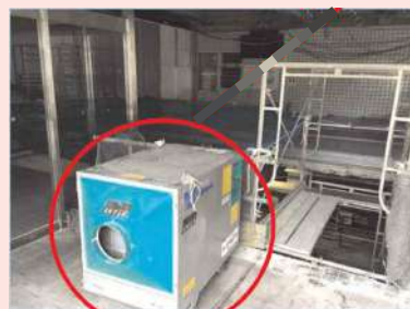
集塵機を設置し室内の換気を実施
