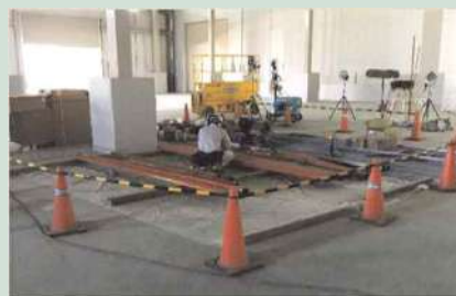
工事エリアの区画を設定して作業
