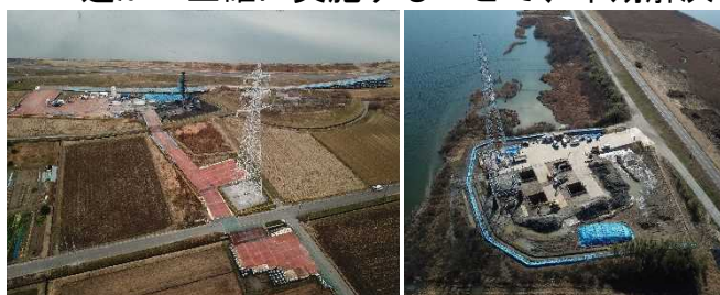
ドローン画像による現場状況確認
