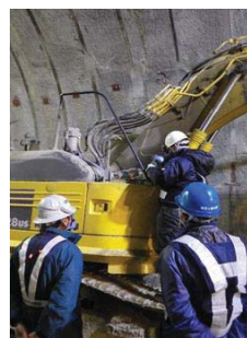
(3) 車両系機械を用いた測定
