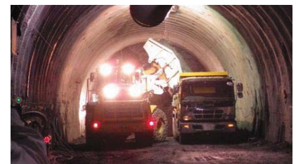
車両系機械による掘削作業
