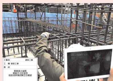
Webカメラを利用した遠隔検査
