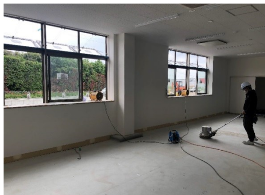
【写真①】送風機による換気(室内側)
