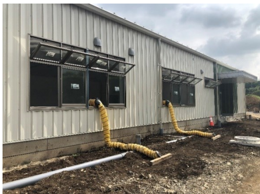
【写真②】送風機による換気(室外側)
