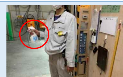
EVの操作盤等の消毒を徹底
