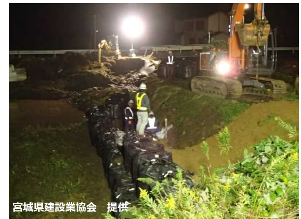
宮城県建設業協会 提供 宮城県建設業協会会員による河川堤防緊急応急 (宮城県津山町)
