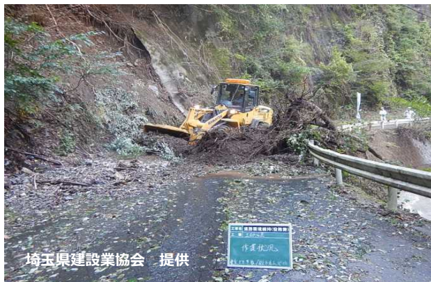
埼玉県建設業協会 提供 埼玉県建設業協会会員による道路啓開 (埼玉県秩父市)
