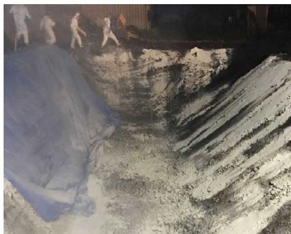
消石灰散布作業（岐阜県建設業協会）
