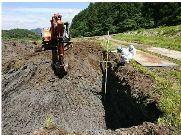
埋却溝掘削作業（岐阜県建設業協会）
