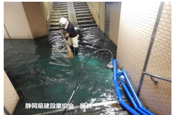
静岡県建設業協会 提供 静岡県建設業協会会員による地下道冠水排水作業 (静岡県焼津市)
