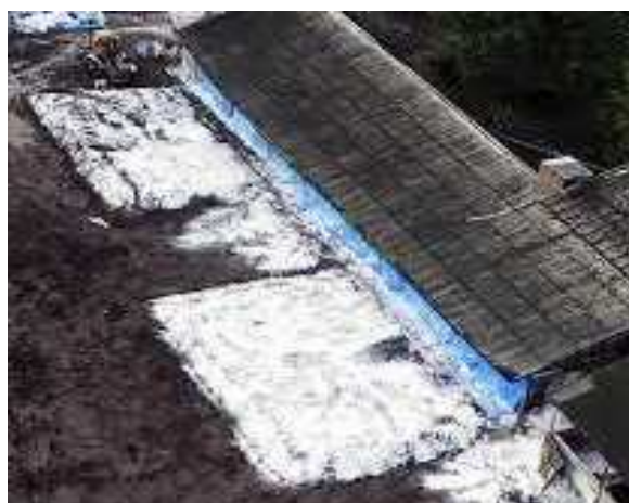
埋め戻し作業後（岐阜県建設業協会）
