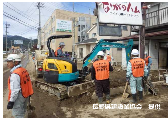
長野県建設業協会 提供 長野県建設業協会会員による堆積物除去 (長野県長野市)
