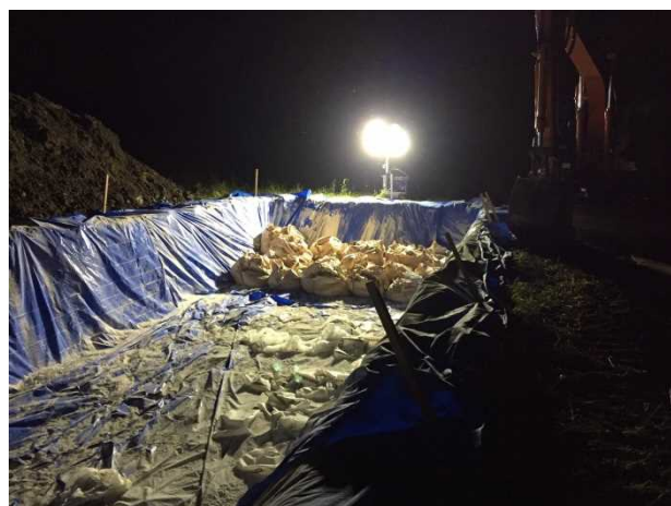
埋却溝への投入作業（岐阜県建設業協会）
