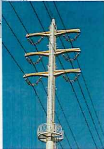
送電線は高い電圧の電気を流しておりますので、電線を支える支持物は、主に鉄塔が使われています。
