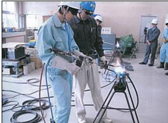
高校生に出前講座で鉄筋ガス圧接の実践的な指導(圧接)
