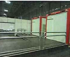
スロープ/手摺の設置
