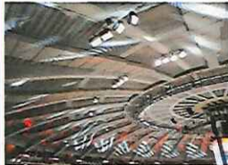
競技用照明の仮設設置 に伴う躯体補強など
