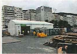
樹脂製養生マット敷設
