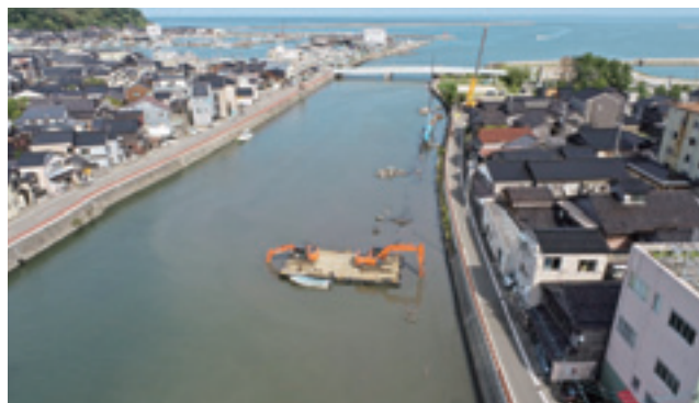
<鋼矢板圧入作業、支障物確認除去作業>
