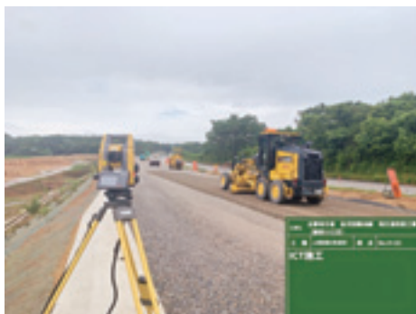
< 上層路盤敷均し (マシンコントロール) >
