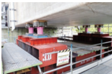
<橋桁のジャッキアップ>
