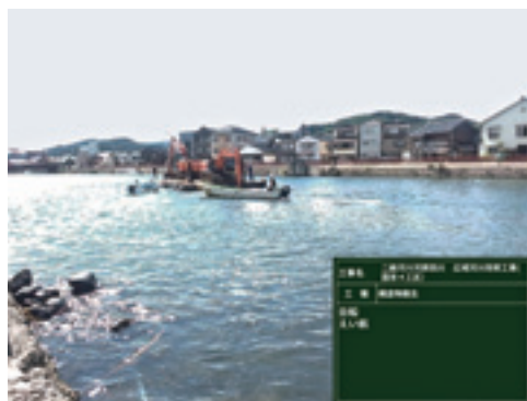
<台船航路及び進入箇所の浚渫>
