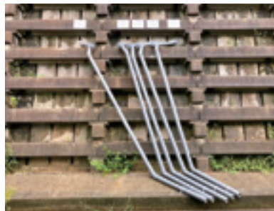
< 工事状況③ >
