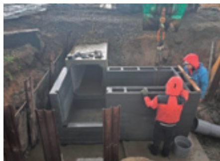
<現場での据え付け>
