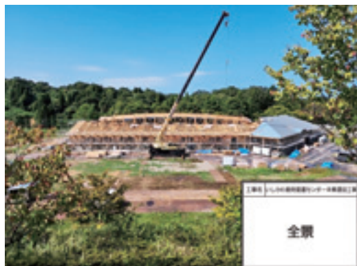
<施工状況（全景）>
