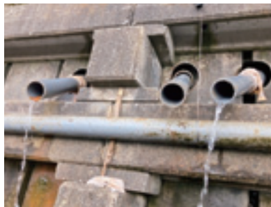
< 工事状況② >
