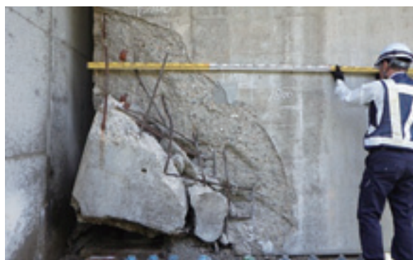
<橋桁の損傷>
