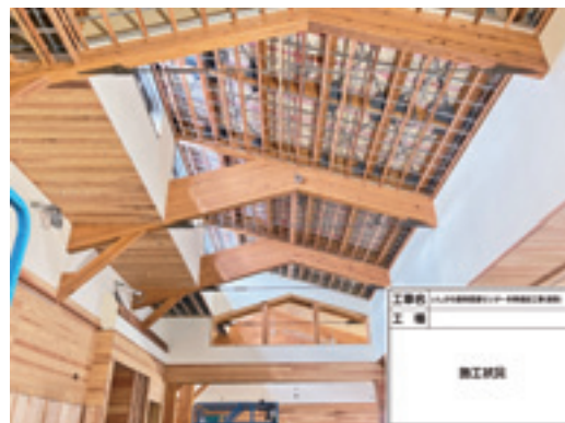
<施工状況（内部）>
