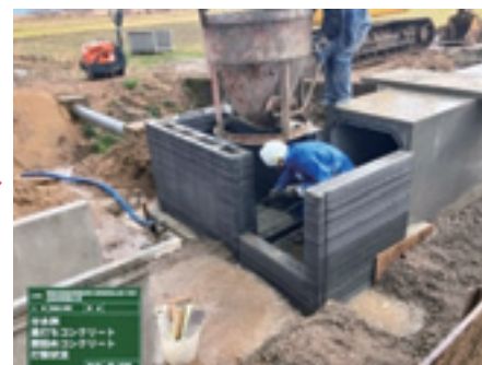
<現場でのコンクリート打設>
