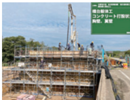
< コンクリート打設 >
