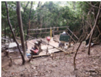
< 工事状況① >
