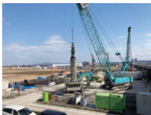
< 場所打ち杭施工状況 >
