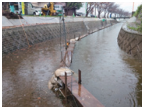
< 仮締切材設置、水替え状況 >
