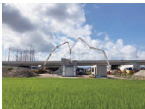
< コンクリート打設状況 >
