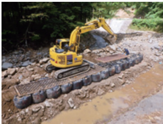
<工事用仮設搬路設置>
