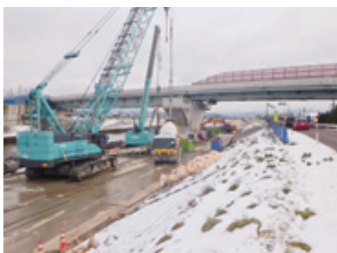
< 土工、土砂掘削状況（三次掘削） >
