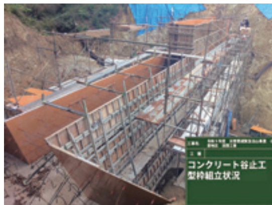
< 型枠組立状況 >
