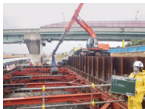
< 場所打ち杭工、コンクリート打設状況 >
