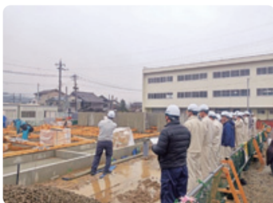
<鳳至小学校での建設現場>
