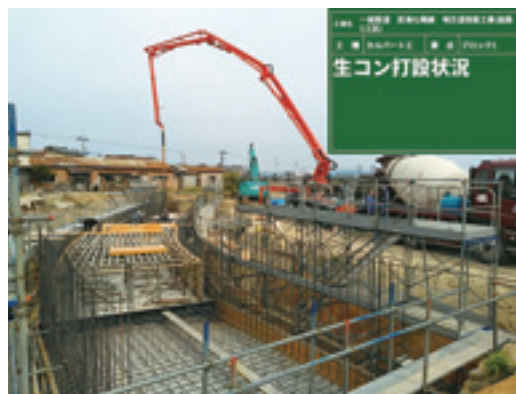
< 生コン打設状況 >
