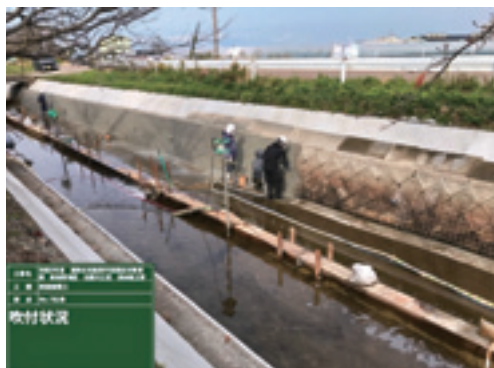
< 高韌性モルタル吹付状況 >
