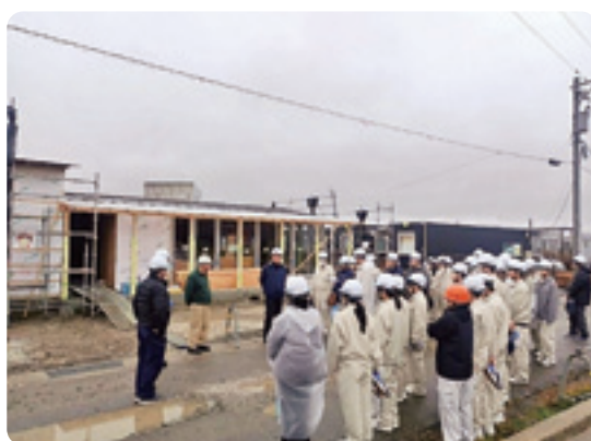
<マリンタウンでの建設現場>
