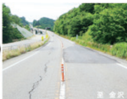
写真-6 応急復旧後（段差のすりつけ）
