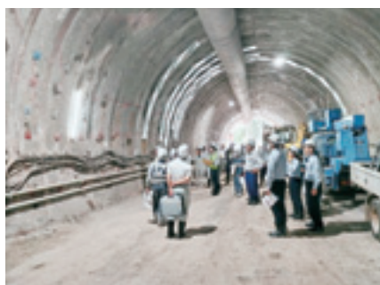
写真2 支保工復旧完了区間
