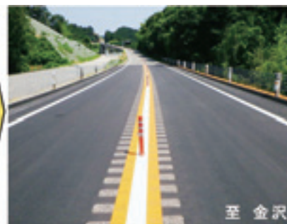
写真-7 本復旧後（舗装の打換え）
