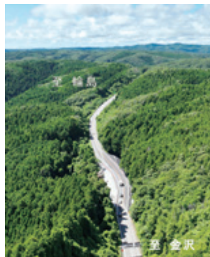
写真-1 対面通行を確保した徳田大津 IC付近の状況
