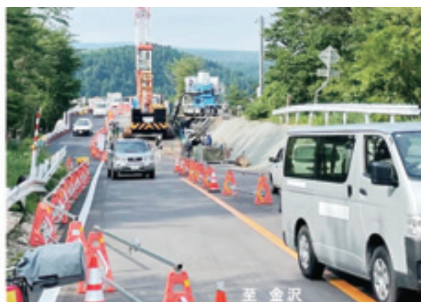
写真-9 応急復旧工事（片側交互通行）の状況
