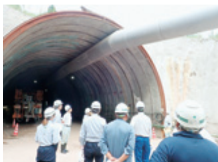
写真1 トンネル坑口
