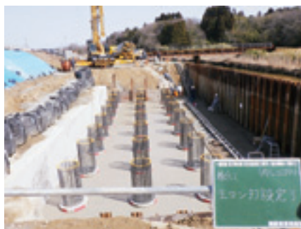
場所打ち杭完了全景（橋台工施工前）
