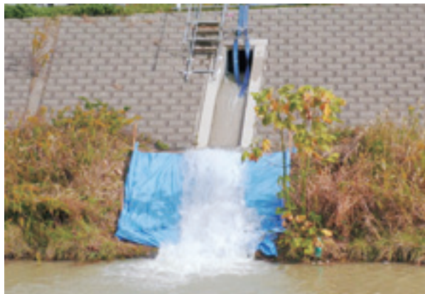
写真-3 排水状況（洗管作業）
