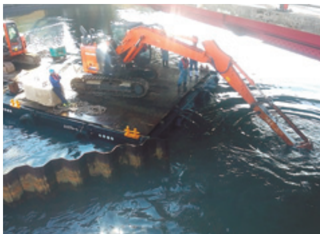
鋼矢板圧入前の支障物確認除去作業 ＊海象に左右される作業
