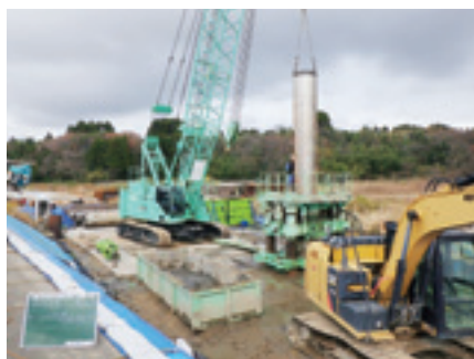
場所打ち杭施工状況
