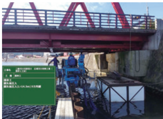
橋下鋼矢板圧入
