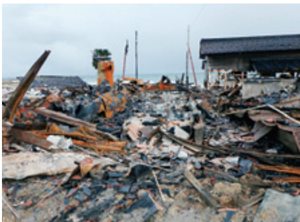
津波により被災
