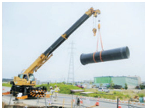
写真-2 耐震管埋設工事
