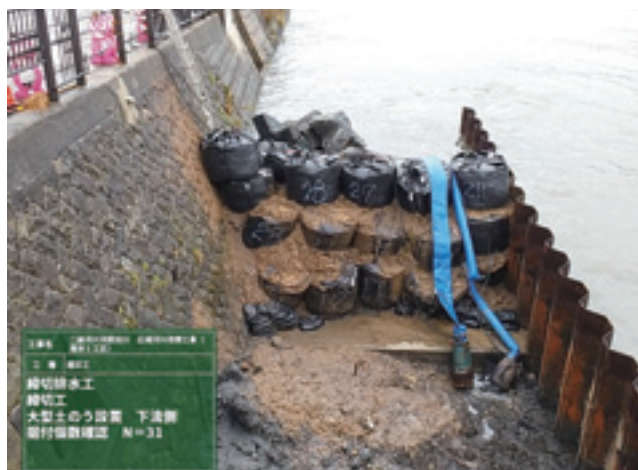
下流側の大型土のう設置状況 設計数：15基 実数：31基
