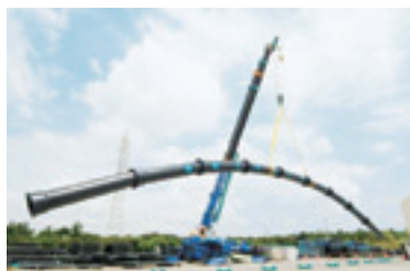
写真-1 新設管の離脱防止テスト
