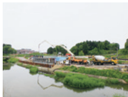
コンクリート打設状況
