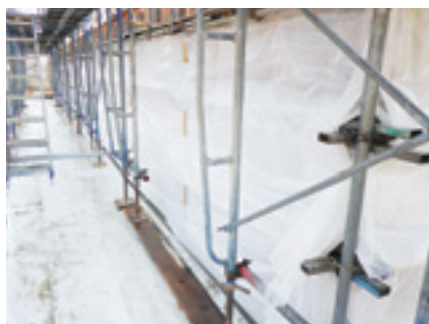
コンクリート養生（エアーバック）
