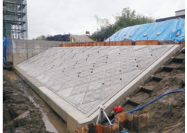
張ブロック設置完了
