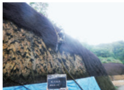
植生基材吹付施工状況
