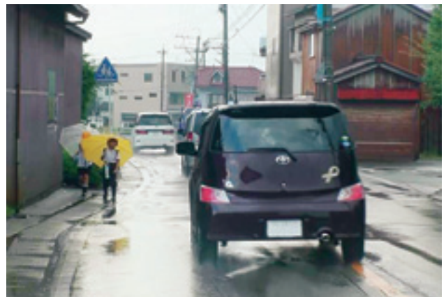
写真-2 歩道の未整備状況
