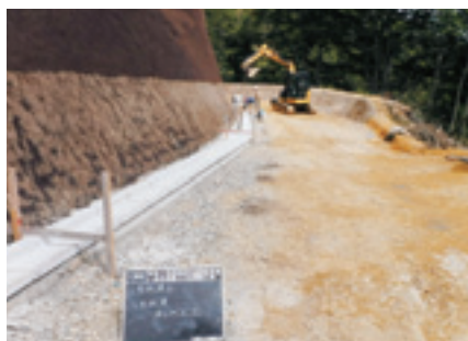
排水構造物施工状況
