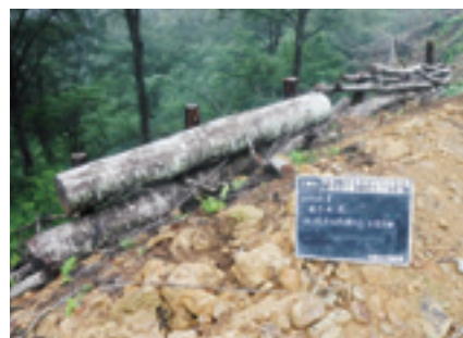
伐木利用した防護柵
