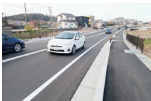
写真-4 完成写真
