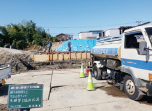
ウエルポイント工ライザー管打込み状況
