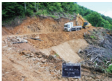
伐木の斜面布設状況
