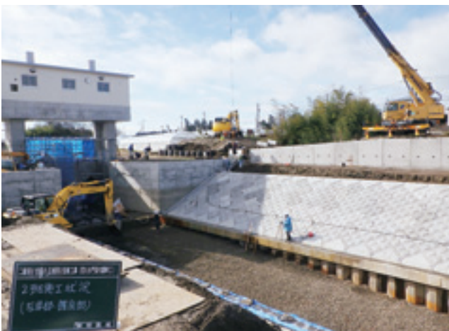
2班施工状況 (擁壁工・護床工)
