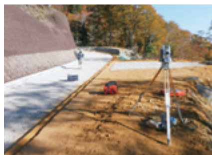
ICT対応の測量機器使用状況
