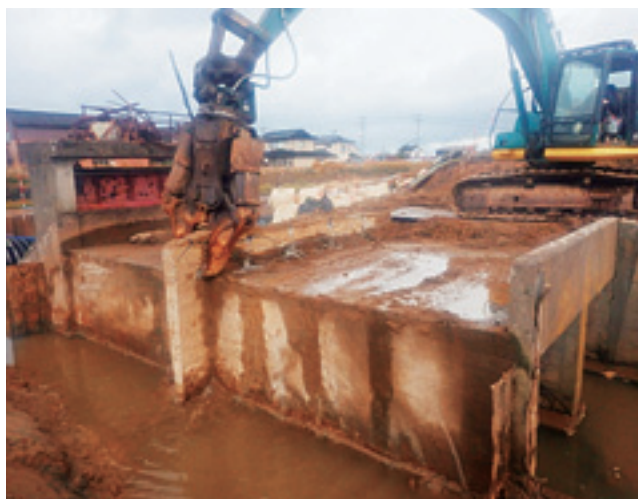
既設樋門取壊し 油圧圧碎機の使用
