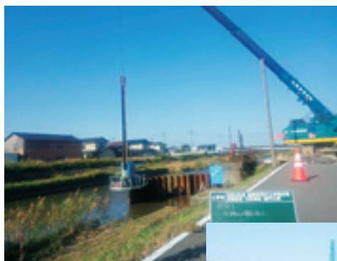
鋼矢板打込み・引抜 油圧杭圧入引抜機の使用
