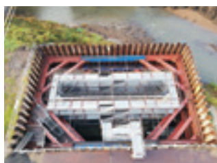
躯体型枠組立①
