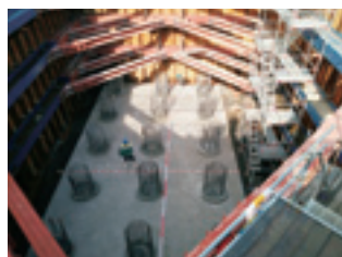
基礎杭出来形④
