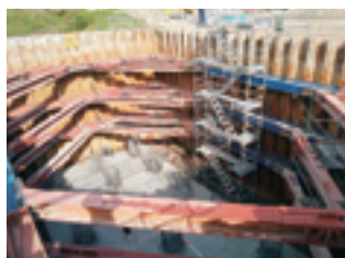
基礎杭出来形③
