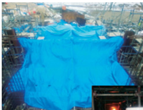
コンクリート打設養生状況
