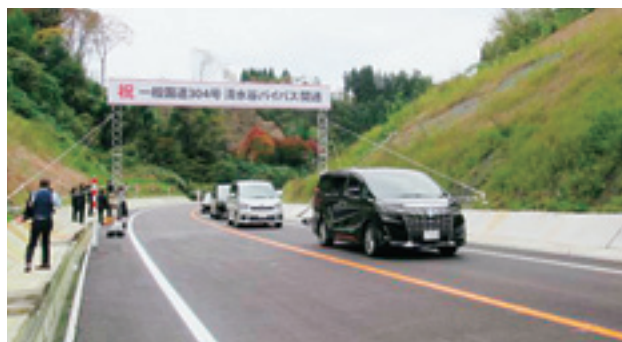
写真-5 開通パレード (富山県側から金沢市側を望む)
