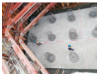
基礎杭出来形①
