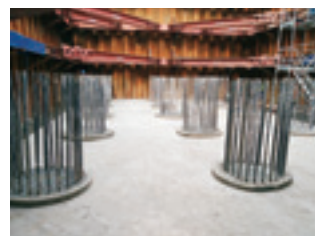
基礎杭出来形⑤
