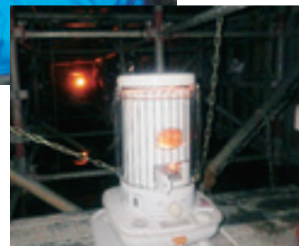
コンクリート打設養生状況
