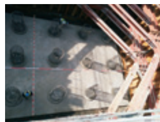
基礎杭出来形②
