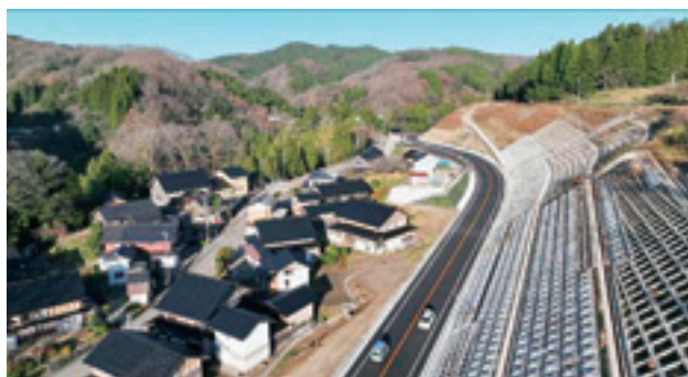
写真-4 清水谷バイパス整備状況 (金沢市側から富山県側を望む)
