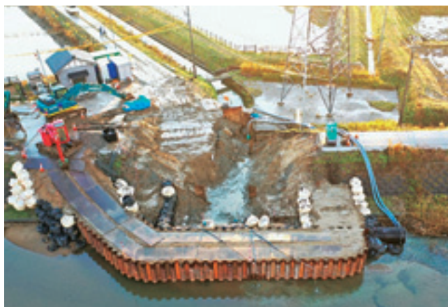
2重締切鋼矢板の設置状況
