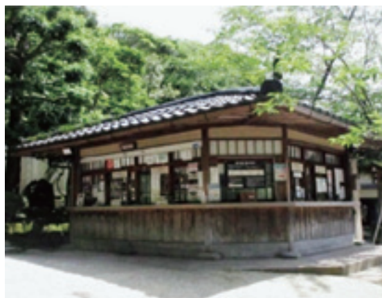
写真-1 桂坂料金所（リニューアル前）
