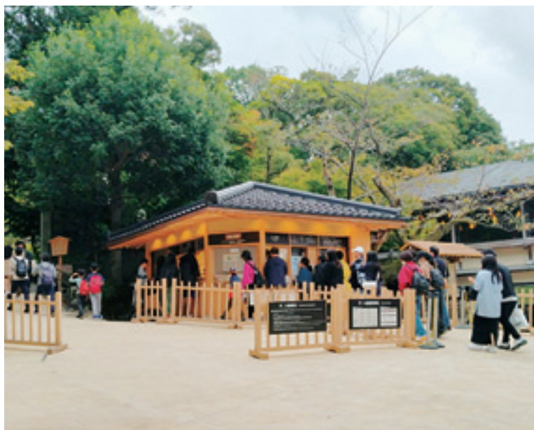
写真-3 桂坂料金所（供用開始日の様子）
