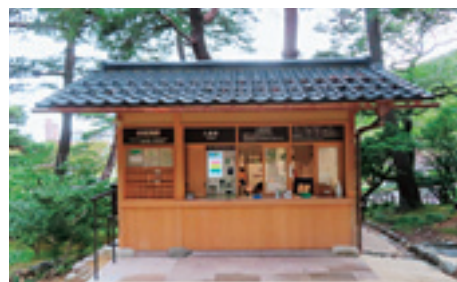
写真-4 真弓坂料金所（リニューアル後）
