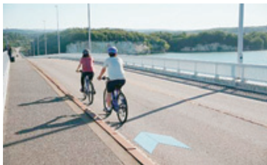
写真-4 矢羽根型路面標示の設置
