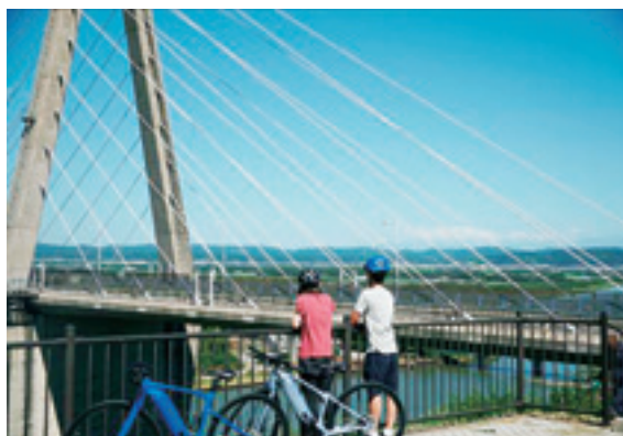
写真-1 サポート施設 (道の駅 内灘サンセットパーク)
