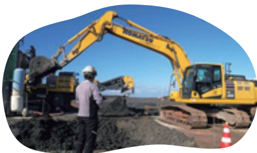
金沢港の土砂運搬工事現場で
