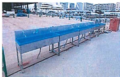
現場の手洗い場所の増設
